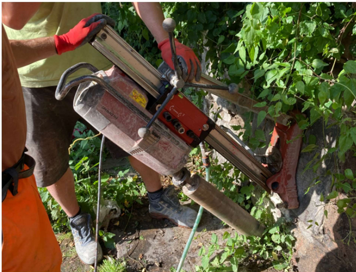
Poloha vrtné soupravy pro zjištění úrovně základové spáry (úhel přibližně 45°)
