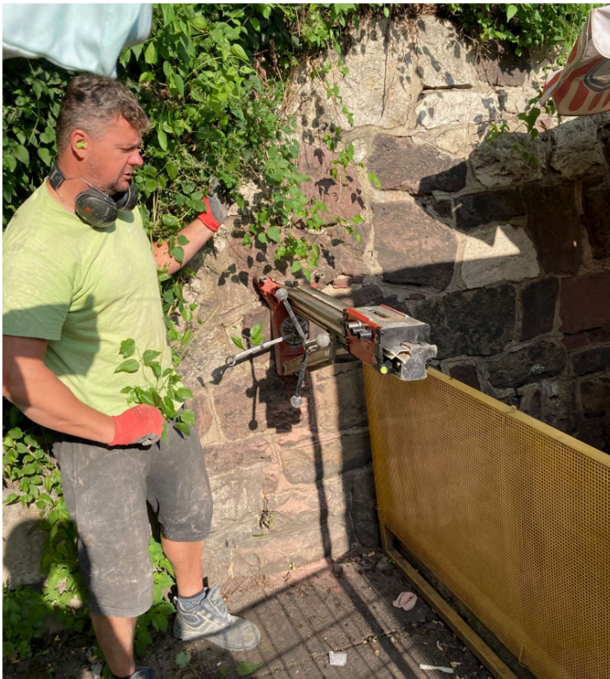
Provádění vodorovného vrtu pro zjištění šířky opěrné zdi
